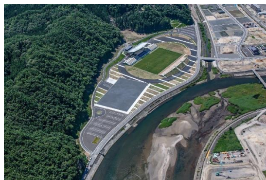
スタジアム竣工
