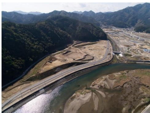
釜石鶴住居復興スタジアム造成状況
