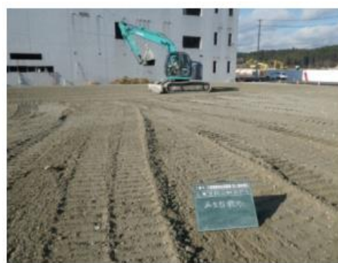
敷均し・転圧状況
