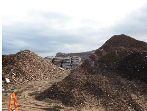
東日本大震災 (平成 23 年 3 月)
