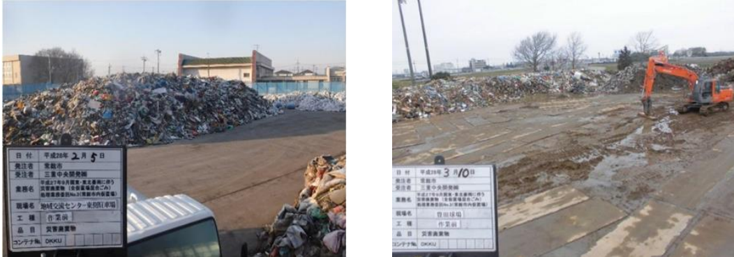
図. 3-14 混合廃棄物の仮置場状況（大栄環境㈱様 ご提供）
