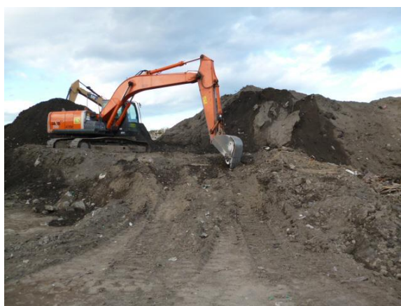
東日本大震災 (平成 23 年 3 月)
