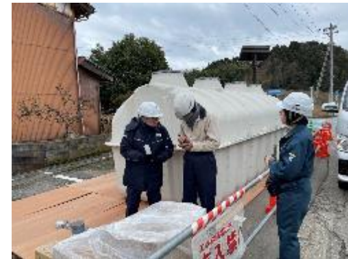
能登町での浄化槽の状況確認
