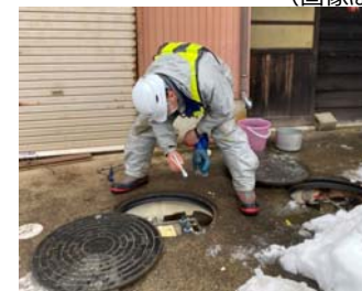
地震により浮き上がった浄化槽 (画像は七尾市内の例)
