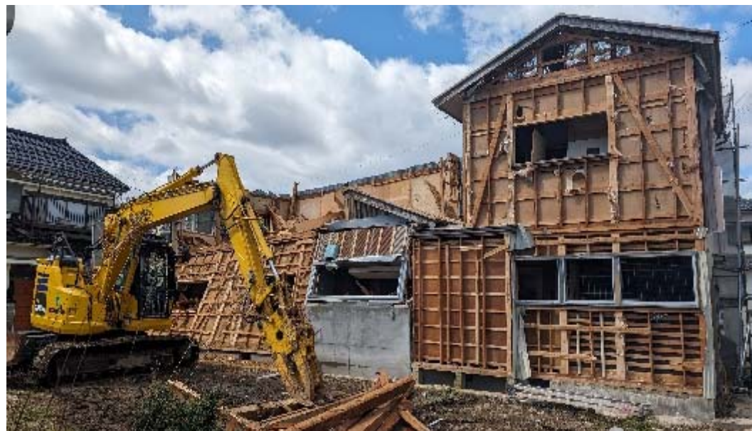
解体工事の様子
