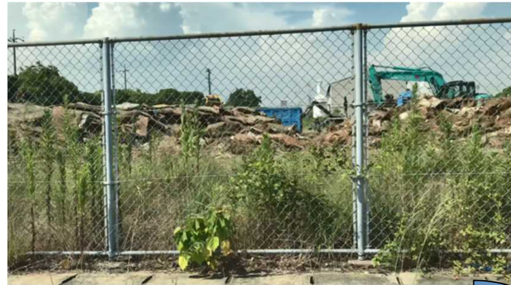
⑭玉島フラワーフィールド(20,000㎡) ※ 解体に伴う廃棄物 一次仮置場(選別、破碎、仮置き)
