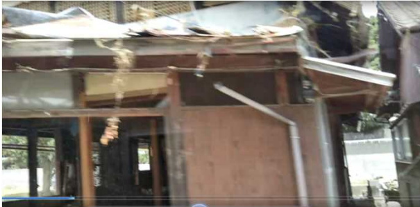
1 狩野川ダム下流 森山地区
