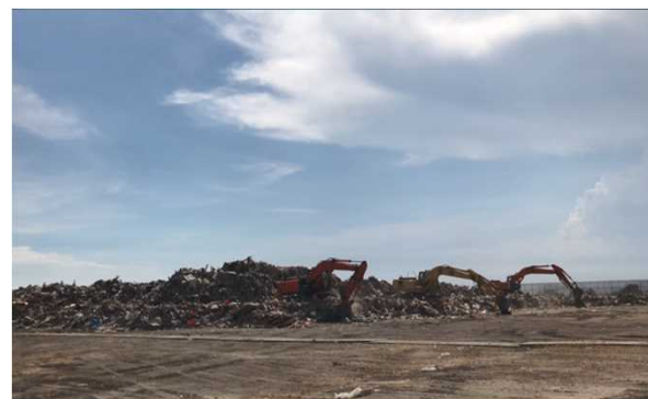
置場②4ha③6ha(破碎、選別) 倉敷市、総社市、矢掛町
