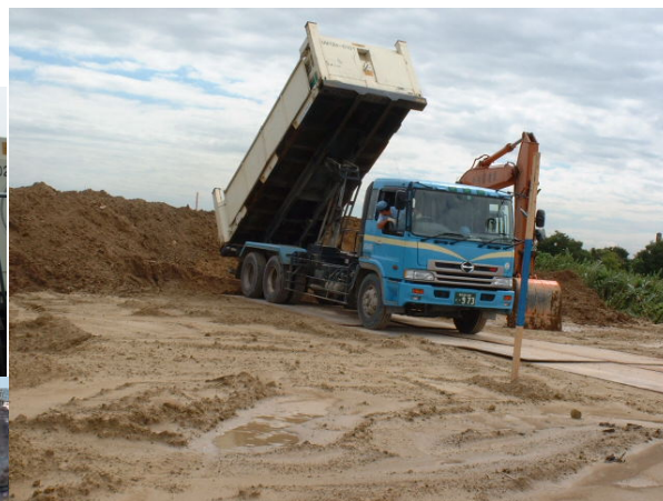
ダンプアップによる土砂の取卸し
