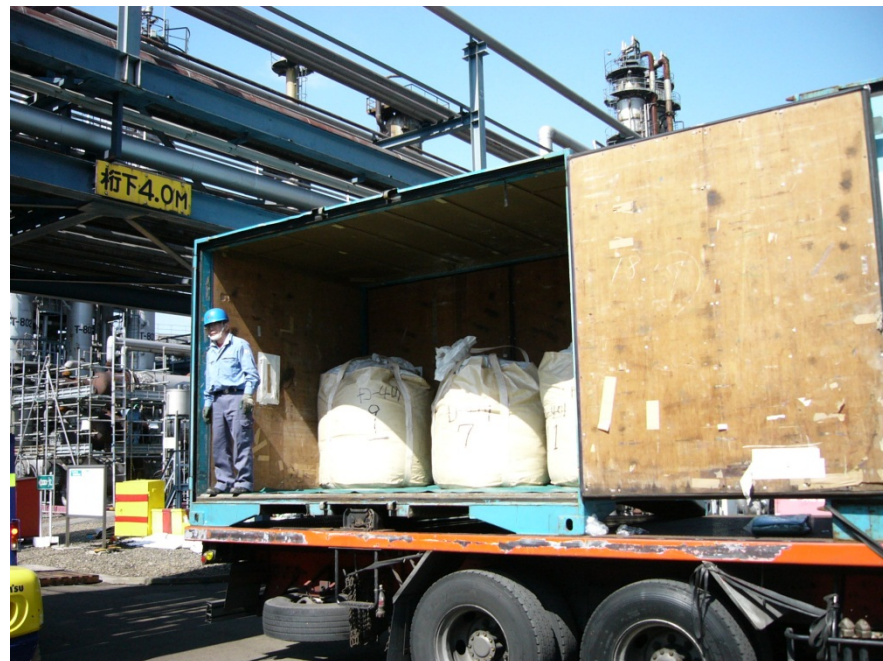
中間処理施設(秋田県内)での汚染土壌の取卸し
