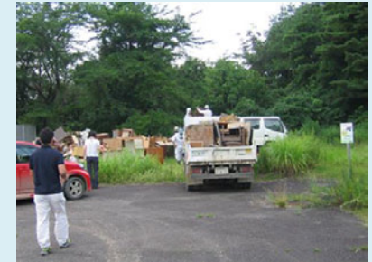
災害廃棄物の仮置場の視察(7/27)
