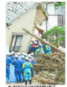
広島市東区山手町。土砂災害で、住宅が完全に埋没された。7月25日撮影。広島市消防局提供
