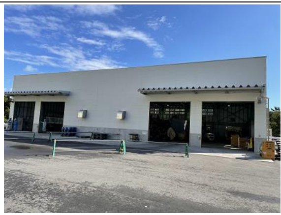
島後清掃センターストックヤード
