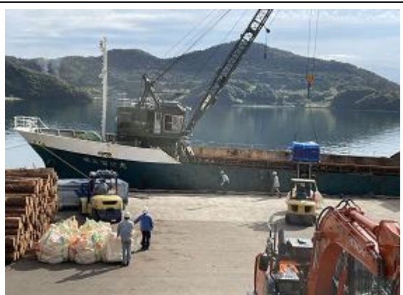
小田岸壁全景（ガット船への積込2）
