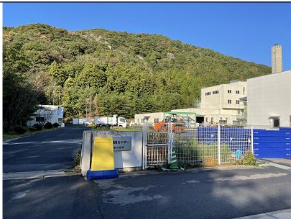
島後清掃センター出入口
