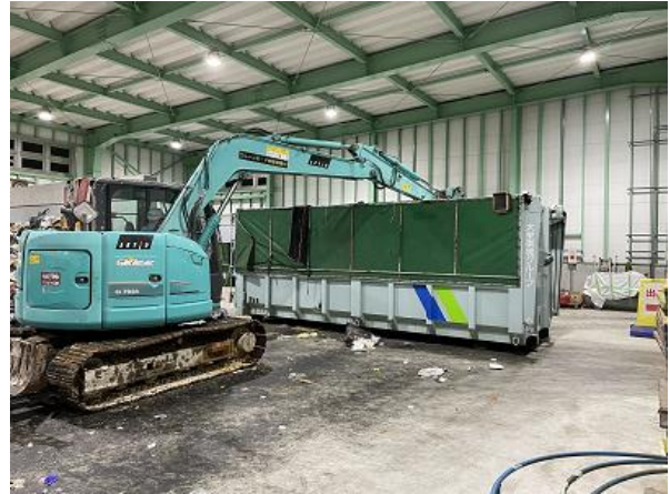
バックホウによる転圧 1
