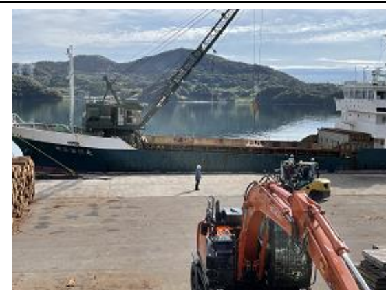
小田岸壁全景（ガット船への積込完了）
