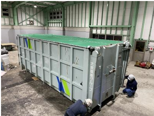
天蓋設置完了
