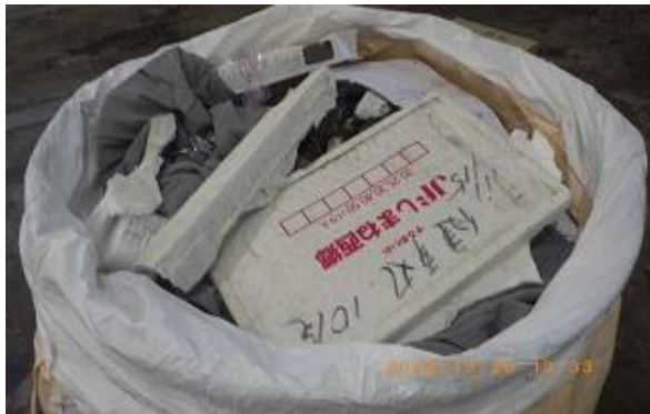
1 m 3 フレコンバッグ積込完了
