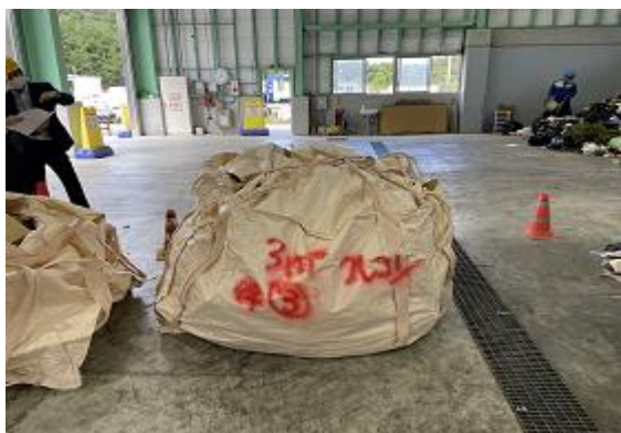
3 m 3 フレコンバッグ積込・梱包完了
