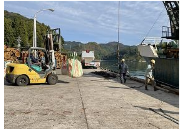
1 m 3 フレコンバッグの積込 1
