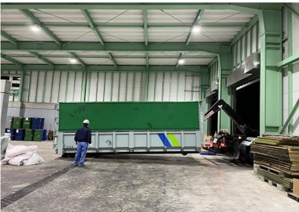
ヤード内に設置された 28 m 3 コンテナ
