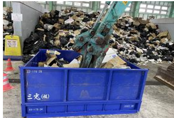
バックホウによる転圧
