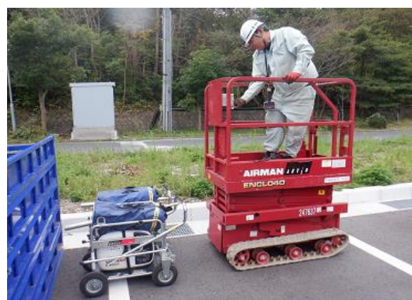
消臭剤散布などに用いる高所作業車
