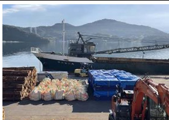
小田岸壁全景（ガット船到着）
