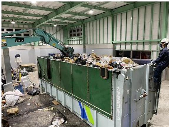
バックホウによる転圧 2
