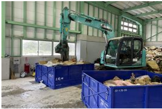
3 m 3 折り畳みコンテナへの積込状況
