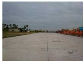
津名港の耐震強化岸壁
