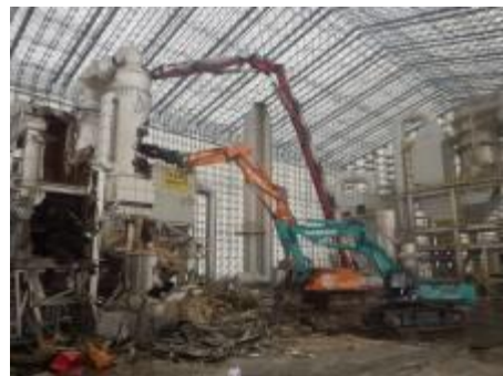
全覆い内部の解体状況 (宮城県気仙沼処理区小泉) (気仙沼JV)
