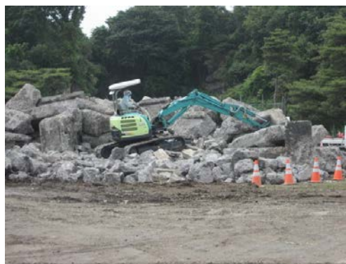
写真 3.2.2.2 コンクリートガラの破碎
