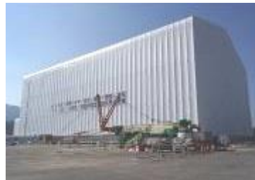
解体中 (民家が近いので全覆 密閉養生方式を採用)
