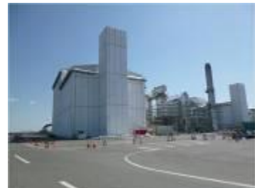
炉別部分覆い密閉養生方式 による解体撤去 (石巻JV)
