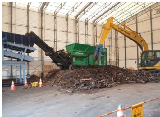
写真 3.2.2.3 木くずの移動式破碎機
