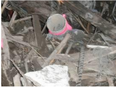
(1) 火災予防対策（放熱管の設置） 岩手県宮古市宮古運動公園二次仮置場
