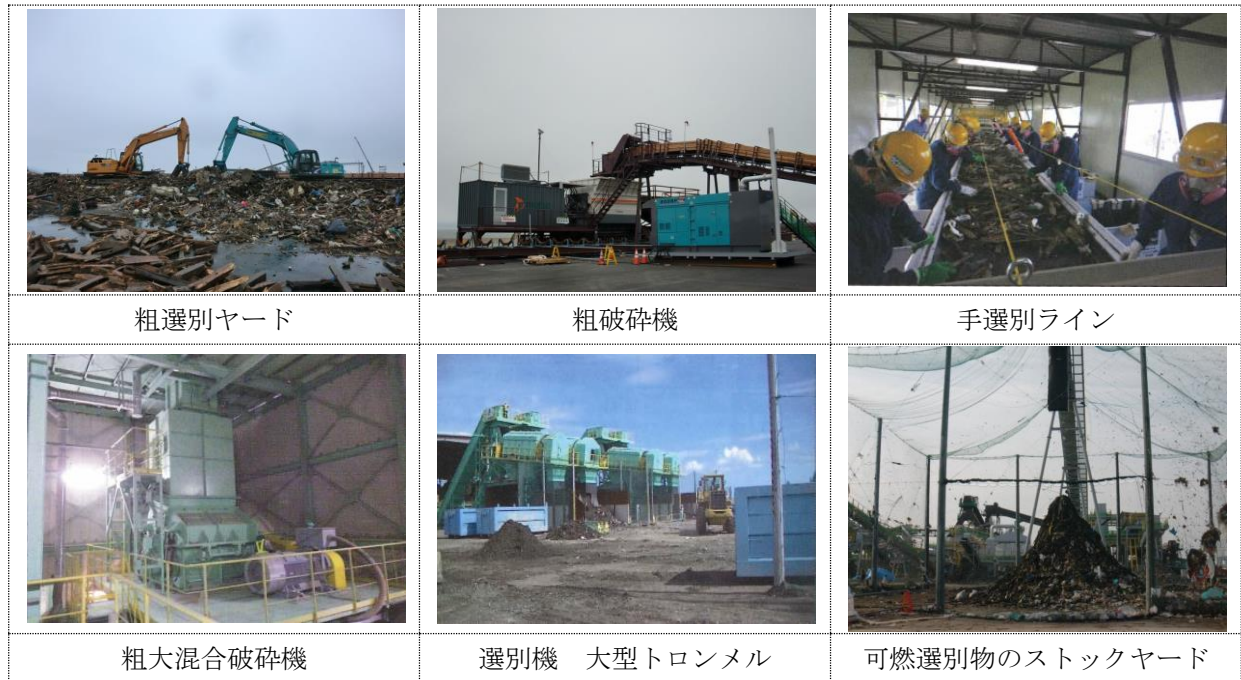
写真 1.2.1 大規模固定式破碎・選別施設例
