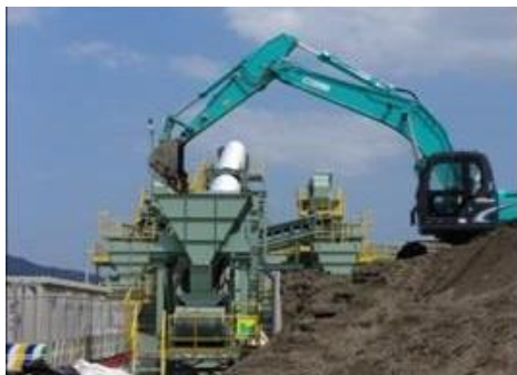
写真 3.2.2.4 (左)津波堆積物処理施設 投入作業
