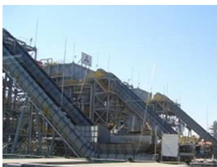
仮設焼却施設
