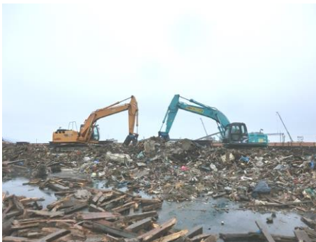
一次破砕：重機による粗破砕 混合した廃棄物を敷きならし、 重機により選別する
