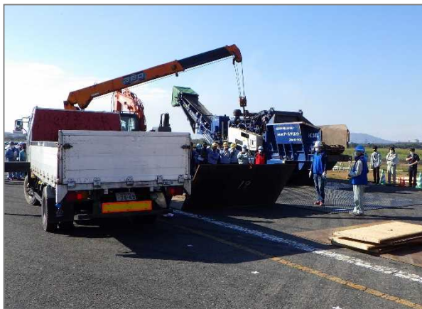
仮置場における搬入車両等のための鉄板設置訓練（岡山県）
