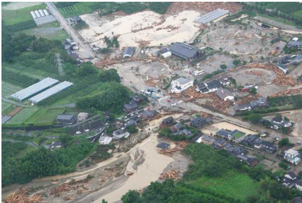
出典：「平成29年7月九州北部豪雨 朝倉市災害記録誌」(平成31年3月、福岡県朝倉市) 写真 奈良ヶ谷川下流周辺(山田)の状況
