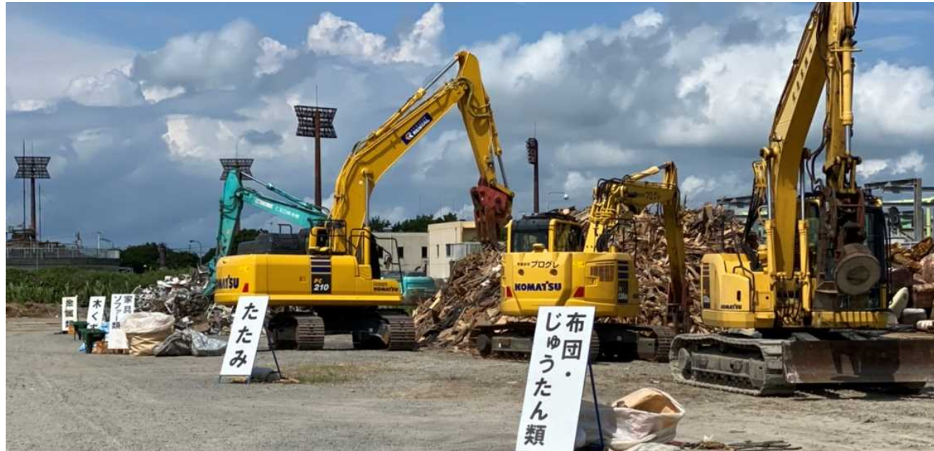
【仮置場全景写真】
