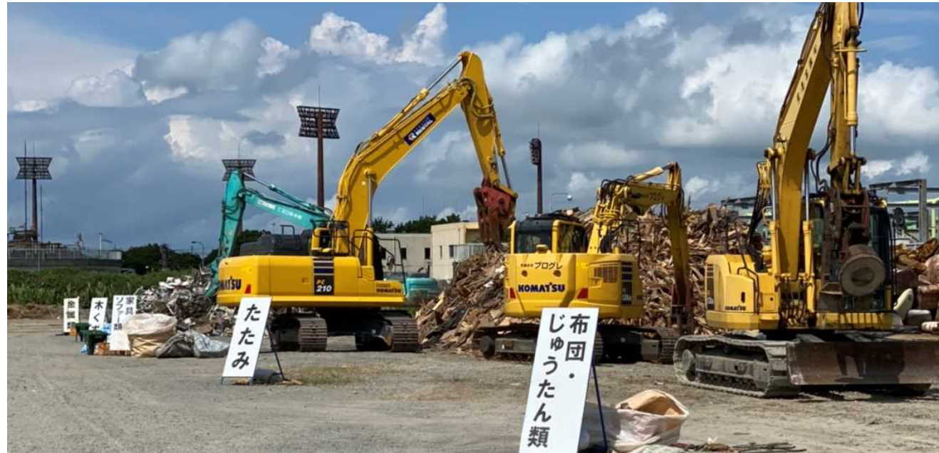
【仮置場全景写真】
