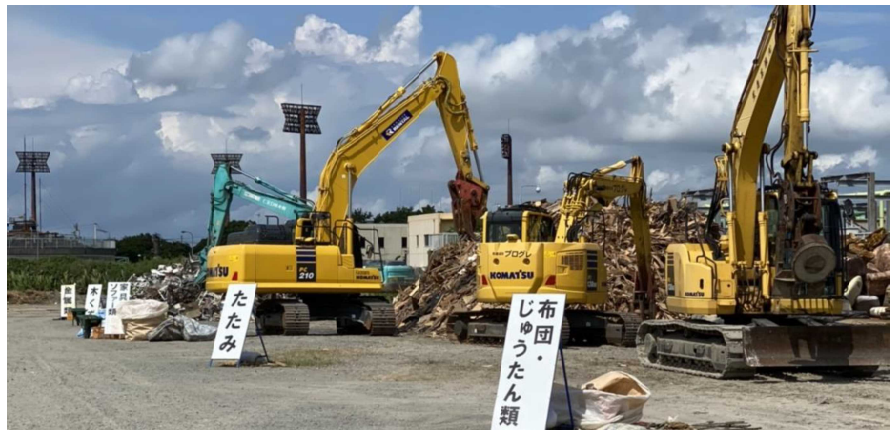
【仮置場全景写真】
