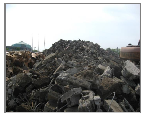
仮置状況(コンクリートブロック)
