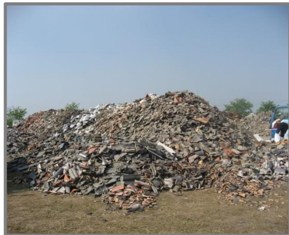
仮置状況(瓦等)
