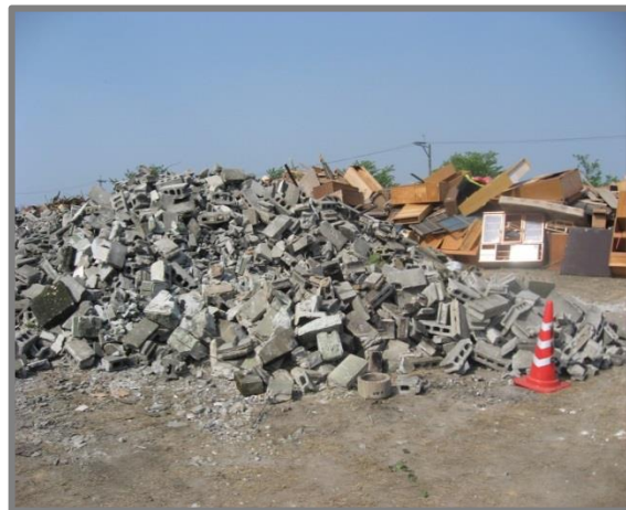
仮置状況(コンクリートブロック)
