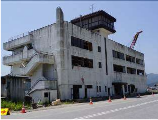
解体前 (H25年6月5日撮影)
