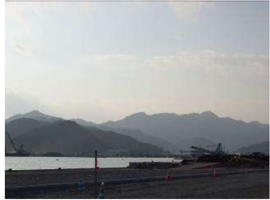
解体後 (H25年10月31日撮影)
