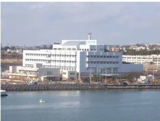
解体前（H24 年 12 月 13 日撮影）
