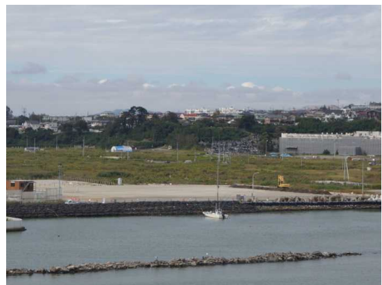
解体後（H25 年 10 月 1 日撮影）
