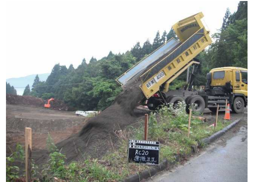
大船渡綾里三陸線小石浜地区道路改良工事 (H25 年 7 月開始)
