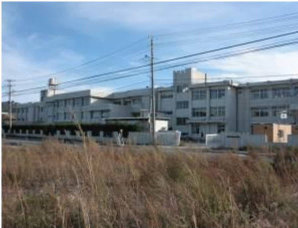
解体前（H24年11月15日撮影）
