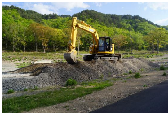
宮古市中の浜園地再整備事業 (H25 年 5 月津波堆積物利用開始)
