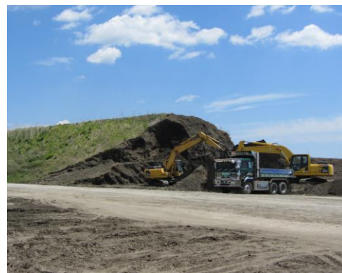
東松島市海岸防災林工事 (H25 年 4 月津波堆積物利用開始)
