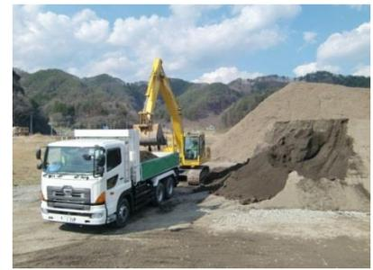
釜石市の再生資材化された津波堆積物の搬出(H25.4.22開始)
