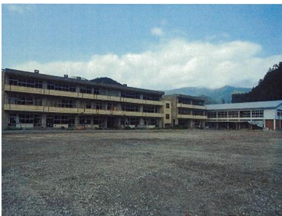
解体前（H24 年 5 月 30 日撮影）
