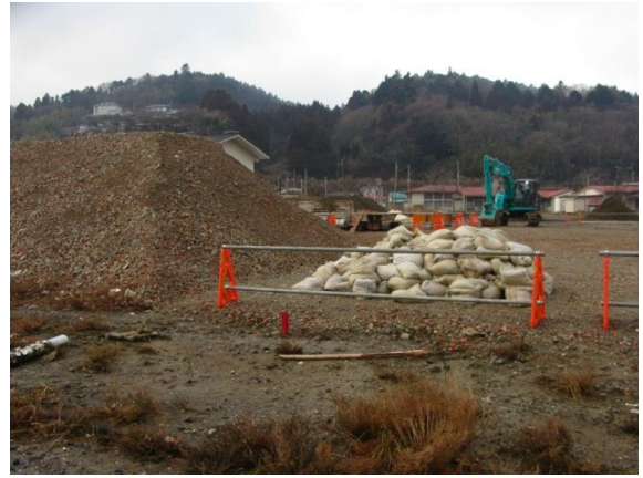
解消後（H25年2月15日撮影） 再生資材置場として使用中
