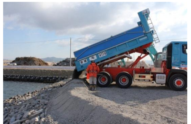
仙台塩釜港石巻港区廃棄物埋立護岸整備事業 (H25 年 2 月 20 日～開始)
