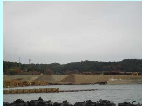
解体 (H24年11月8日撮影)
