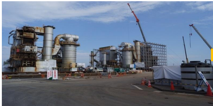
全覆いテント組立
