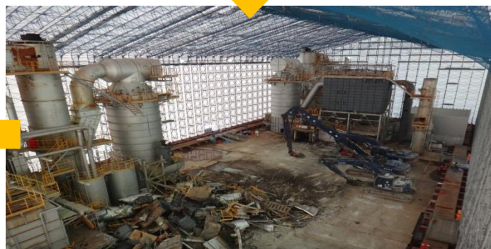
テント内部での焼却施設解体
