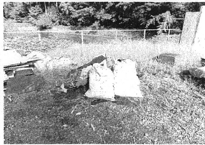
写真12: ⑧荷降場3の状況 その3(防水シート等)
